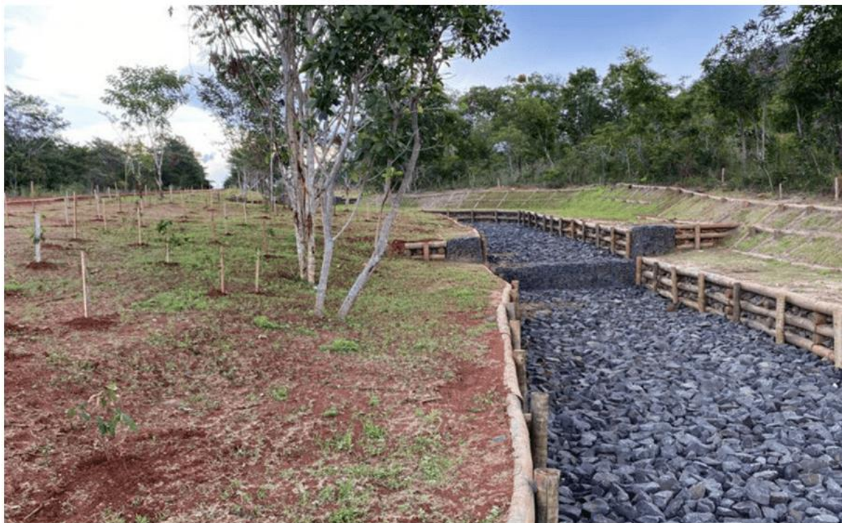
Figura 1 - Obra de contenção da erosão para manutenção da integridade da rodovia
