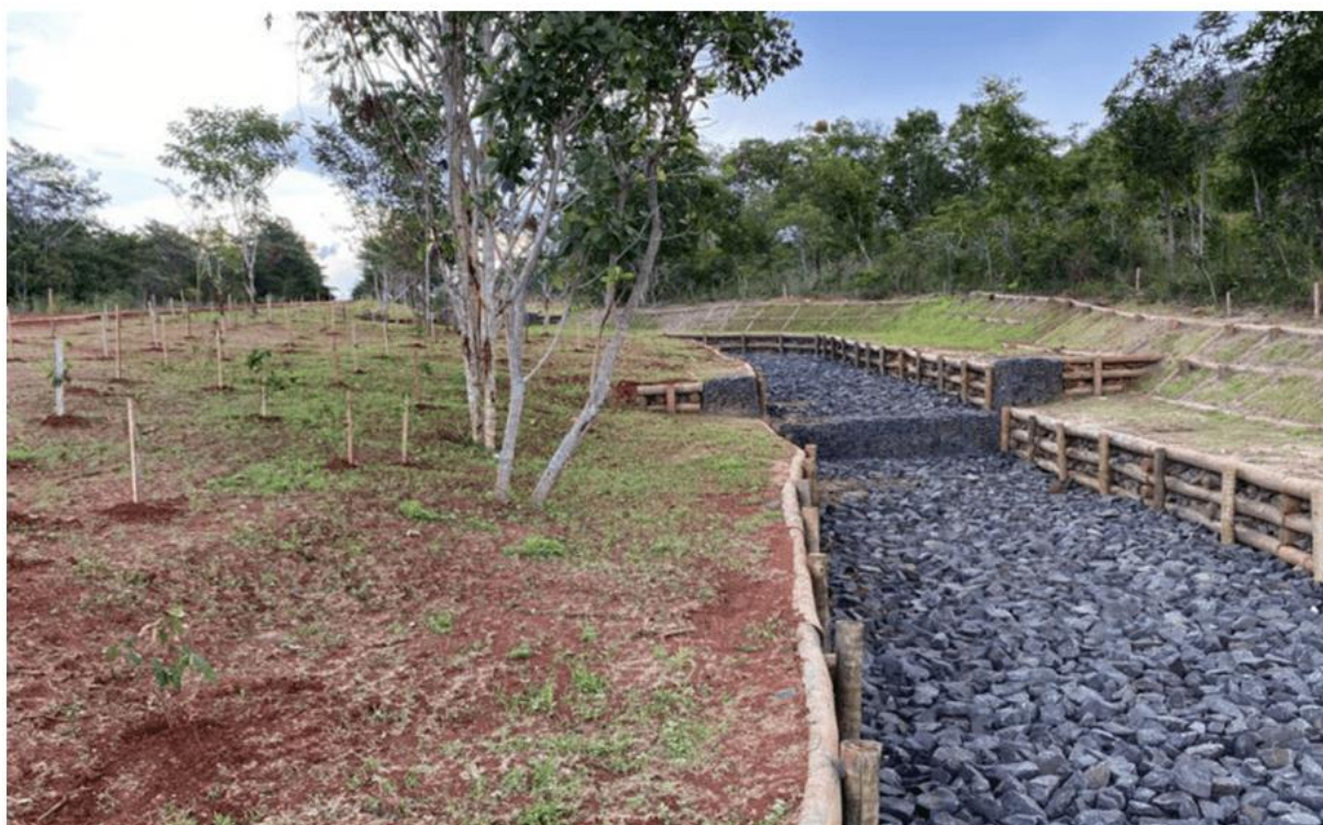
Figura 1 - Obra de contenção da erosão para manutenção da integridade da rodovia
