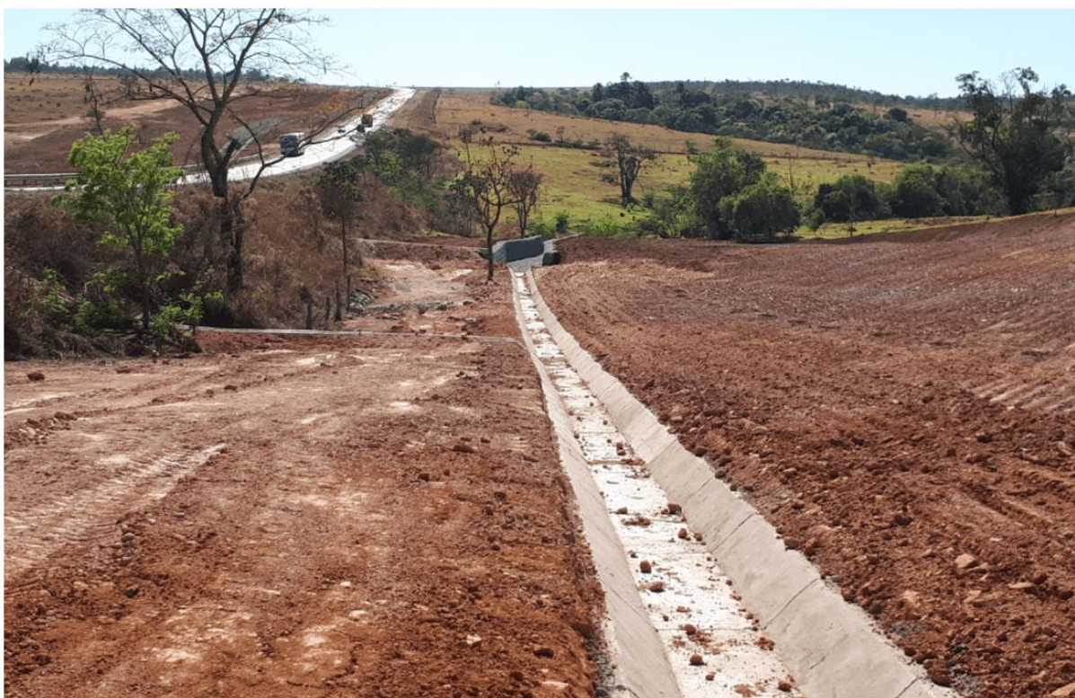
Figura 3 – Serviços topográficos, construção de dispositivo de drenagem, recomposição do solo e revegetação
