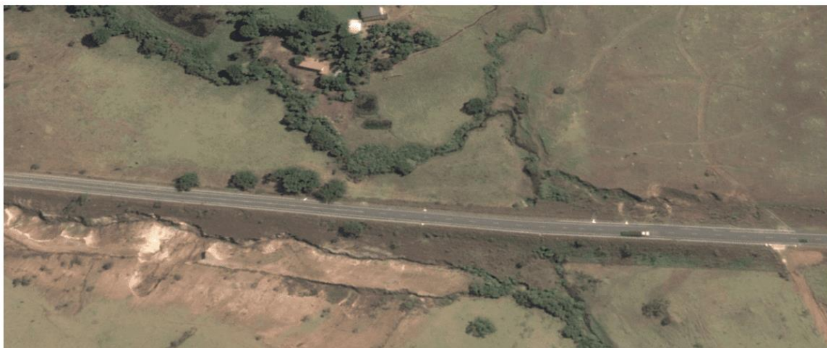
Figura 2 – Rodovia BR-414/GO com processo erosivo em sua margem
