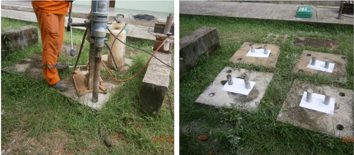
Figura 8: Extração de testemunhos: a) Equipamento de extração (figura à esquerda); b) Testemunhos extraídos de lajes (figura à direita)
