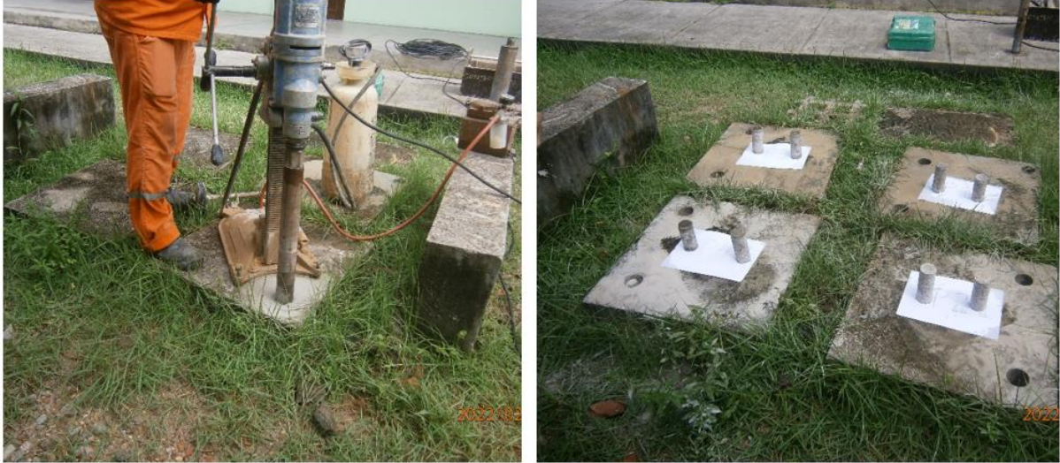
Figura 8: Extracción de testigos: a) Equipo de extracción (izquierda); b) Testigos de prueba extraídos de las losas (derecha)
